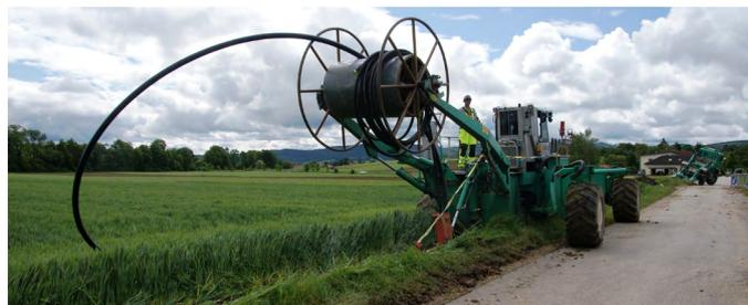
So wie in Poppendorf soll auch Richtung Großaigen die Wasserleitung im Pflugverfahren verlegt werden.
